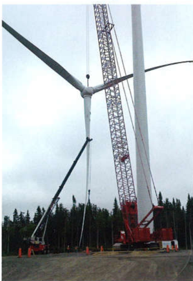
Une Manitowoc 16000, avec l'aide d'une grue d'appoint, lève les nacelles d'une éolienne au Québec (Canada).
